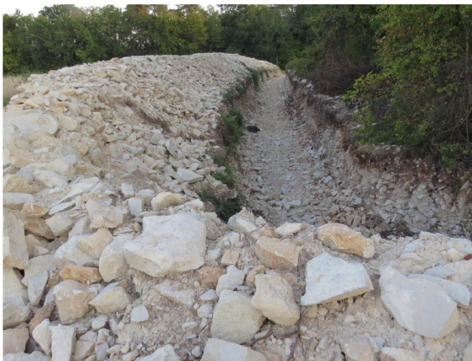
Des talus ont été créés et des fossés creusés pour empêcher les gens d'entrer sur le site et de déposer des déchets.
