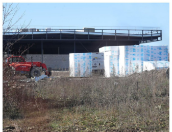
Le lieu où Colruyt est en cours de construction le long de la rocade Ouest, à proximité de l'actuel Grand Frais et de McDonald's.
